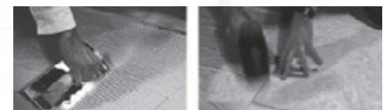
Pour un espacement identique entre les carreaux, utilisez des croisillons calibrés (ils existent plusieurs épaisseurs). C'est simple, pratique et vous assure un travail impeccable.
